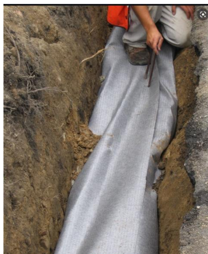
Rys. 4. Wykonanie zakładu i zastabilizowanie za pomocą szpilek
