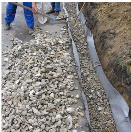
Rys. 3. Układanie kruszywa
