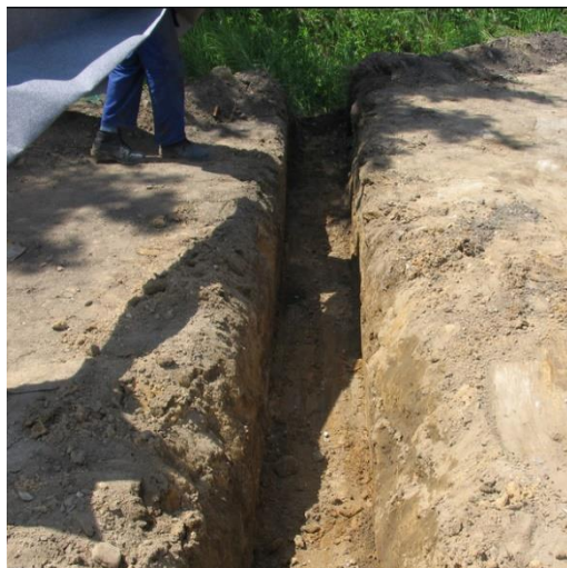
Rys. 1. Rów drenażowy o ścianach pionowych bez umocnienia
