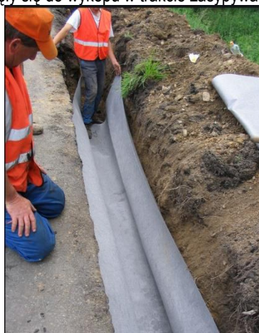
Rys. 2. Układanie geowłókniny w rowie drenażowym
