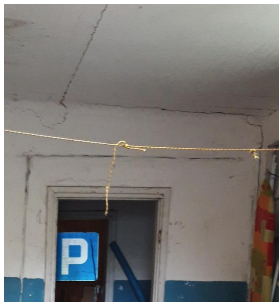
Fot.6 Pęknięcie wzdłużne przy podporze, na łączeniu płyt i w narożniku budynku
