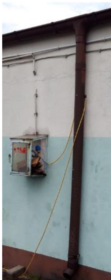
Fot. 12 Rynna i rura spustowa elewacji frontowej budynku.
