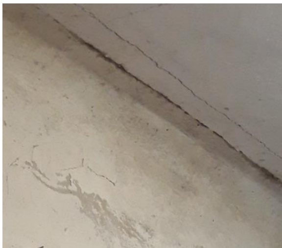
Fot.6 Pęknięcie wzdłużne przy podporze, na łączeniu płyt i w narożniku budynku
