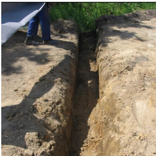
Rys. 1. Rów drenażowy o ścianach pionowych bez umocnienia
