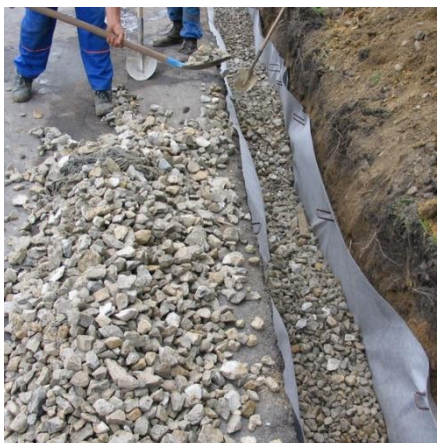
Rys. 3. Układanie kruszywa
