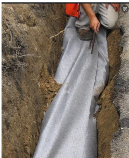
Rys. 4. Wykonanie zakładu i zastabilizowanie za pomocą szpilek
