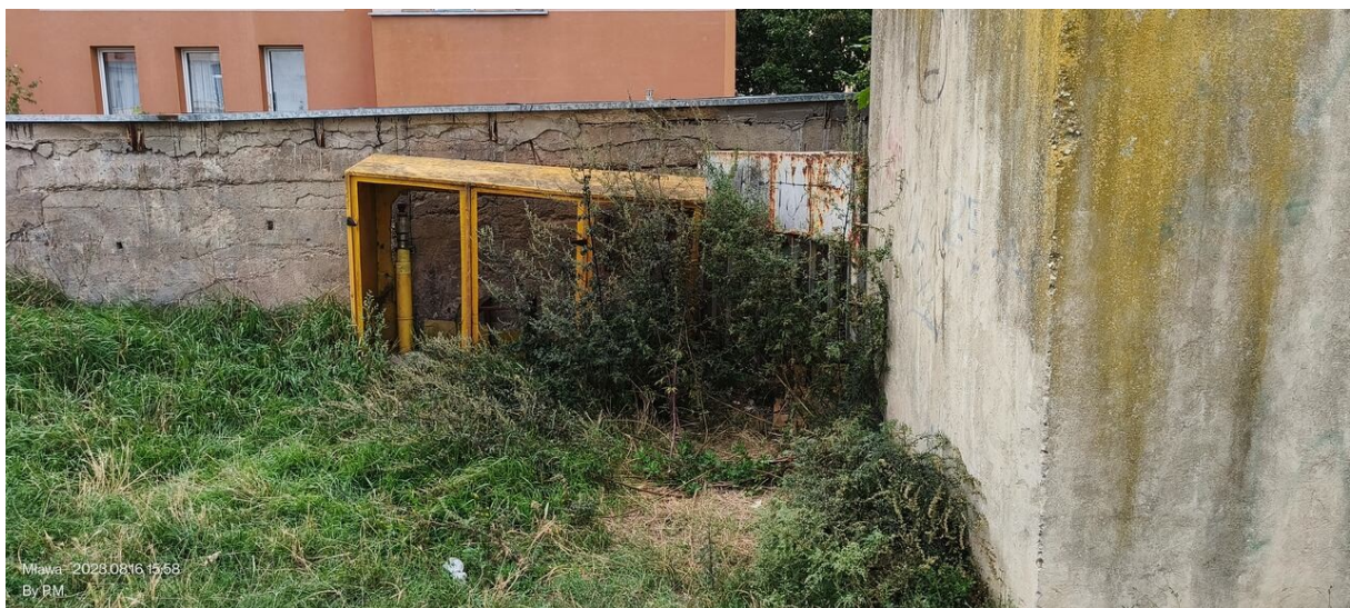
Widok od strony wschodniej; po prawej podstawa komina; na wprost budynek kotłowni oraz pozostałości skrzynki gazowej nieprzeznaczone do rozbiórki.
