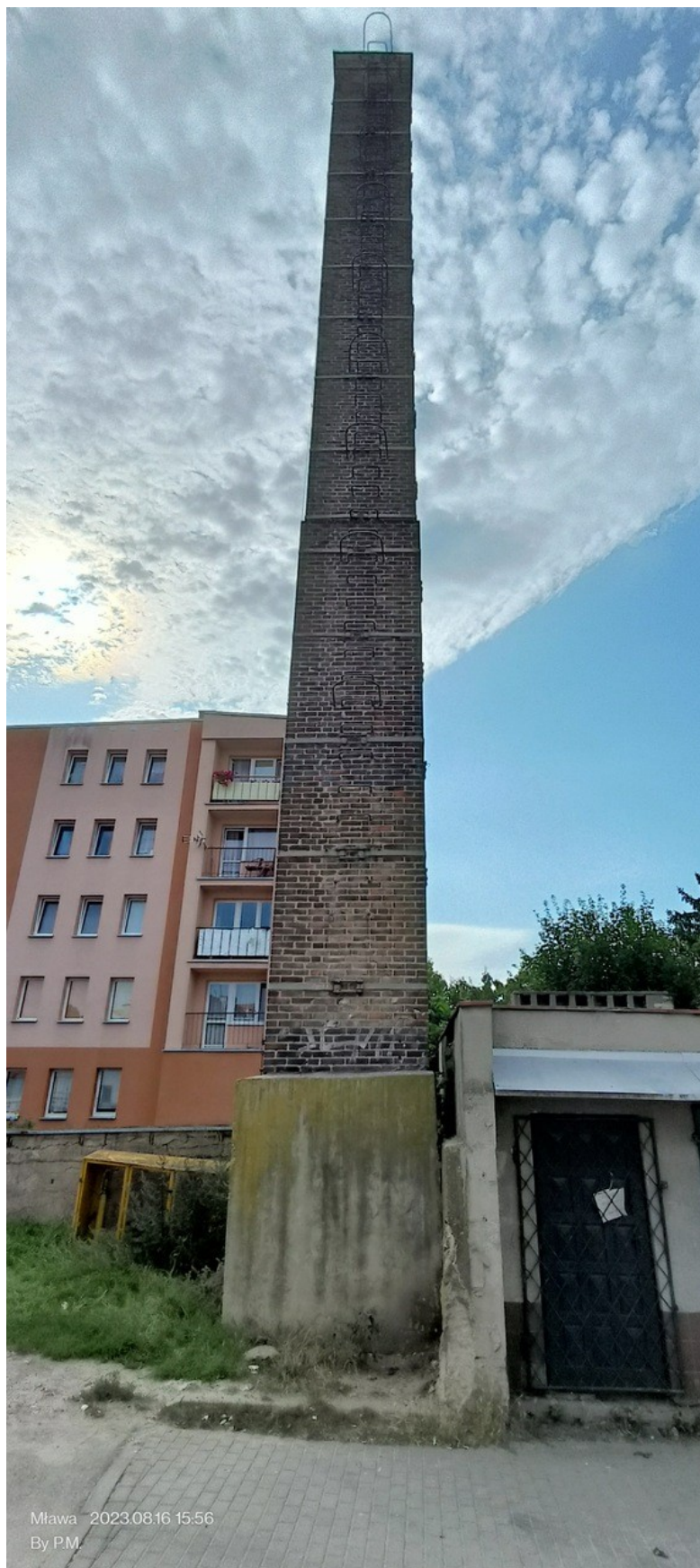
Widok od strony wschodniej; przy kominie widoczne budynki nieprzeznaczone do rozbiórki - po lewej budynek kotłowni, po prawej budynek usługowy.
