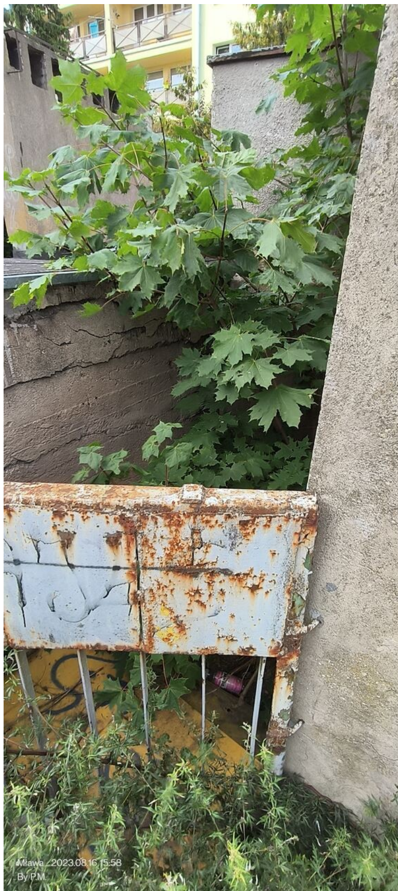
Widok od strony południowej; ogrodzenie stalowe między kominem a budynkiem kotłowni.
