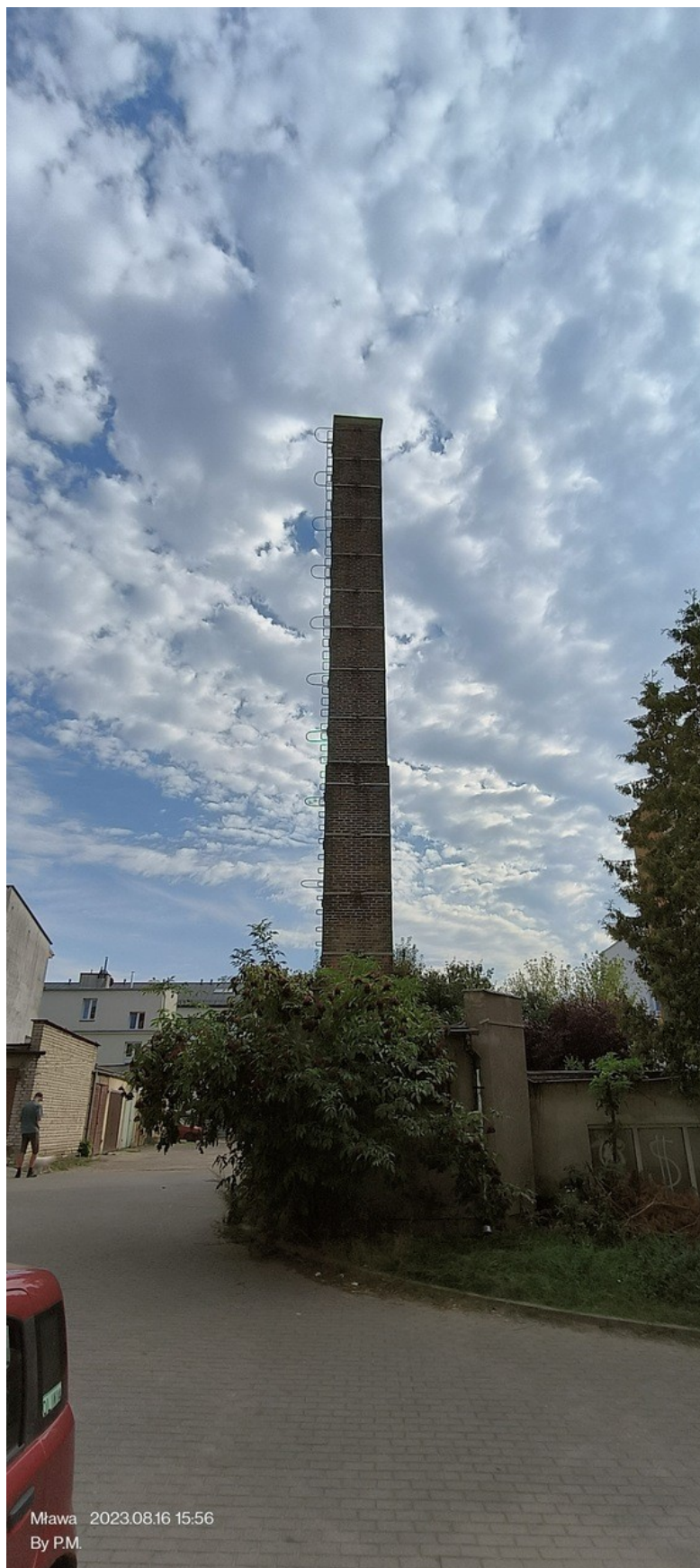
Widok od strony północnej; na pierwszym planie widoczne budynki nieprzeznaczone do rozbiórki.
