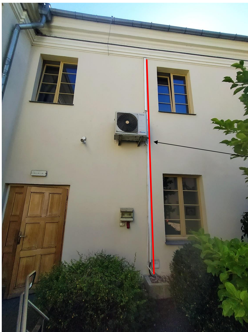
Rys. 2.1 – sposób prowadzenia instalacji po elewacji budynku.
