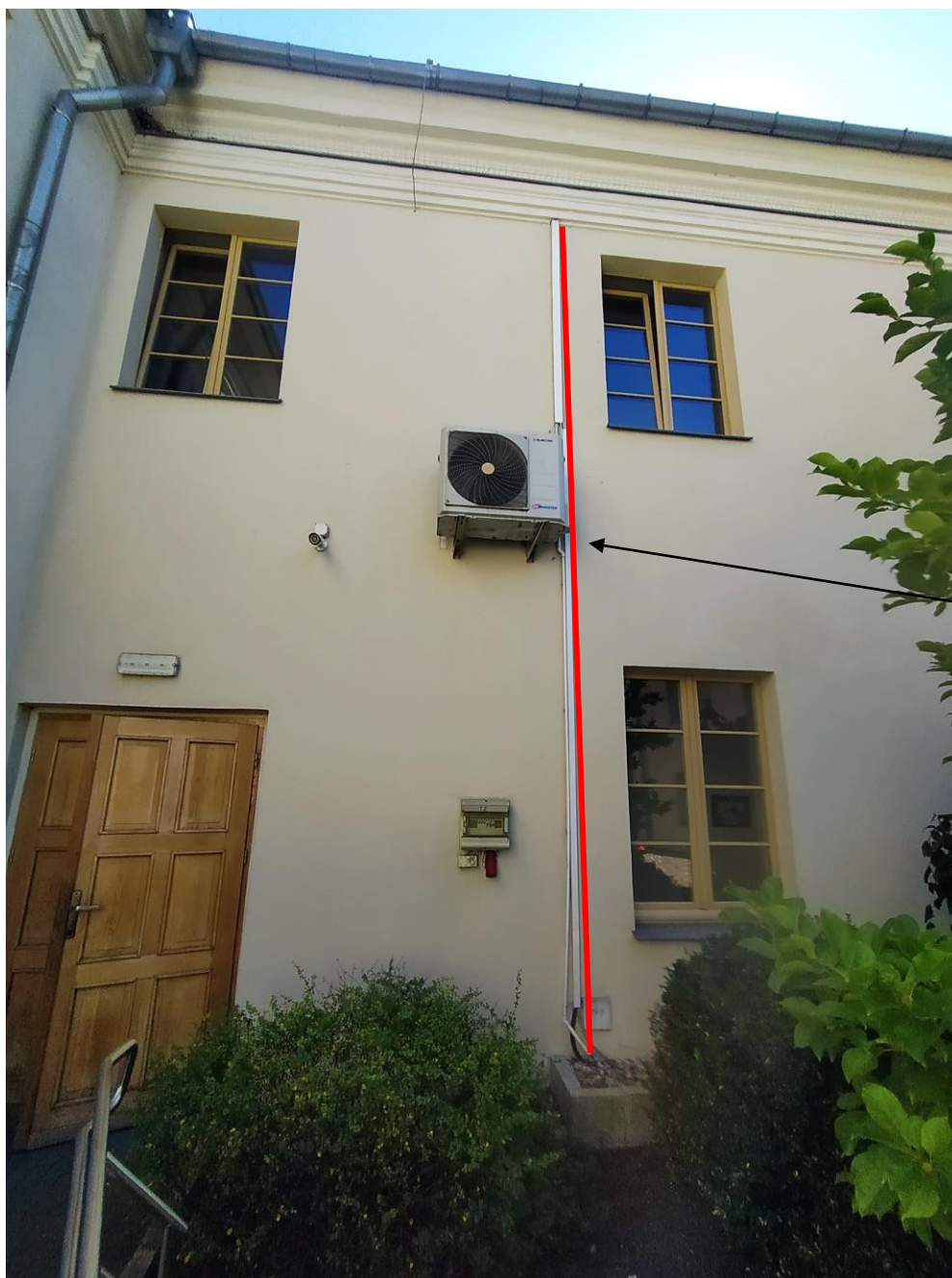
Rys. 2.1 – sposób prowadzenia instalacji po elewacji budynku.
