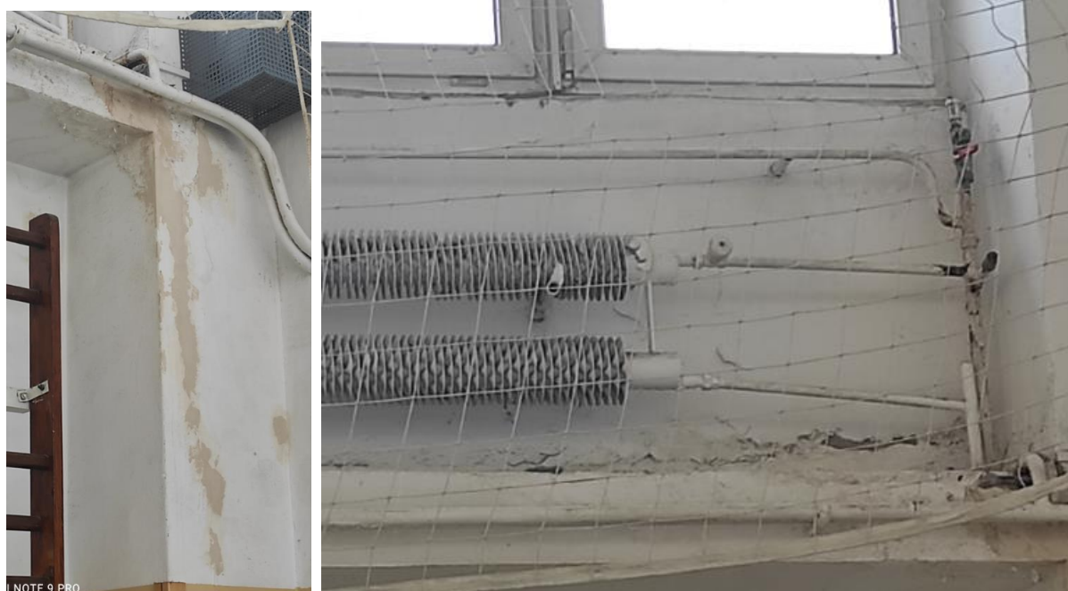
Fot. 1 Zawilgocenie ścian.
