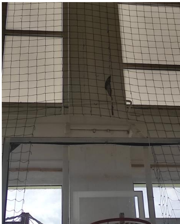
Fot. 2 Zarysowanie na słupie żelbetowym i ubytek w tynku.
