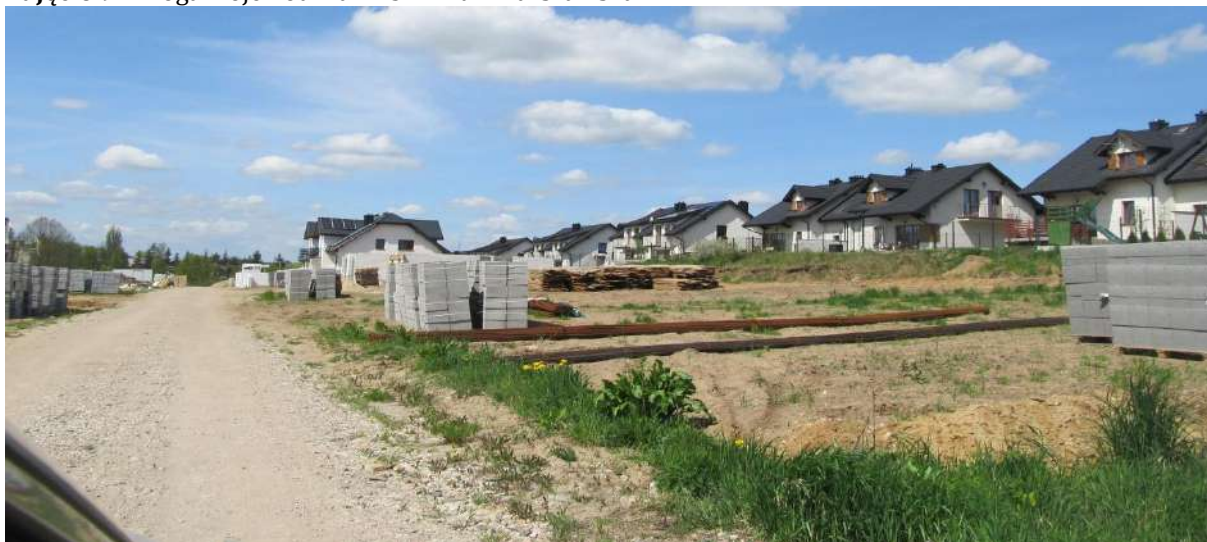
Zdjęcie 10. Zabudowa bliźniacza w części południowej
