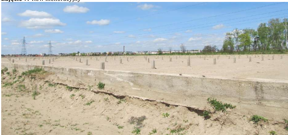
Zdjęcie 8. Szklarnia w fazie rozbiórki, w oddali linie elektroenergetyczne wysokiego napięcia – południowo-wschodnia część obszaru opracowania
