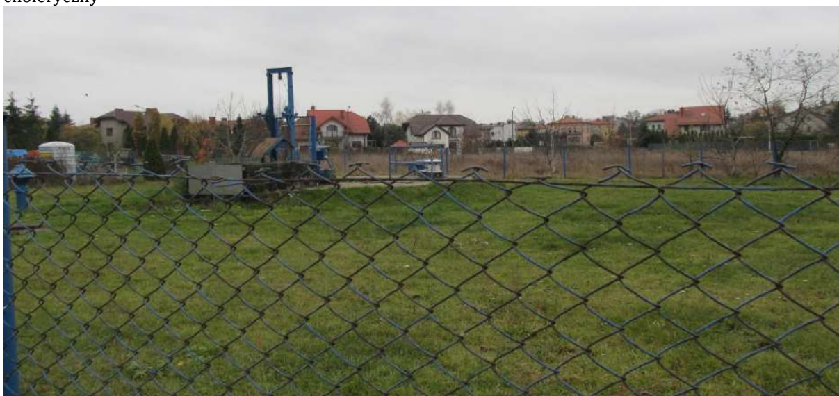
Zdjęcie 9. Teren przepompowni ścieków
