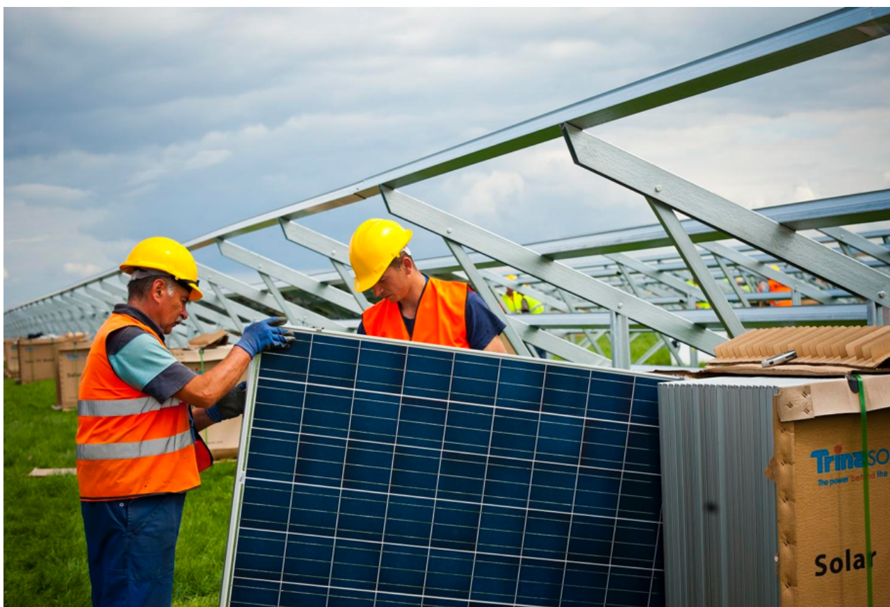
Fot. 3. Montaż konstrukcji stalowych i paneli fotowoltaicznych (źródło: Remor Solar).
