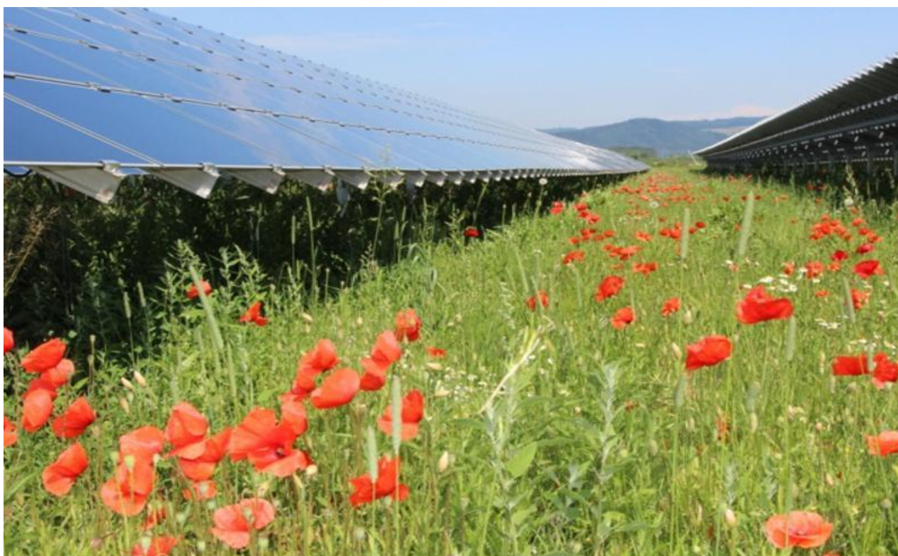
Fot. 12. Przykłady zróżnicowanej szaty roślinnej porastającej tereny farm fotowoltaicznych (źródło: „Solar power plants in the nature”, Belectric Solarkraftwerke GmbH).
