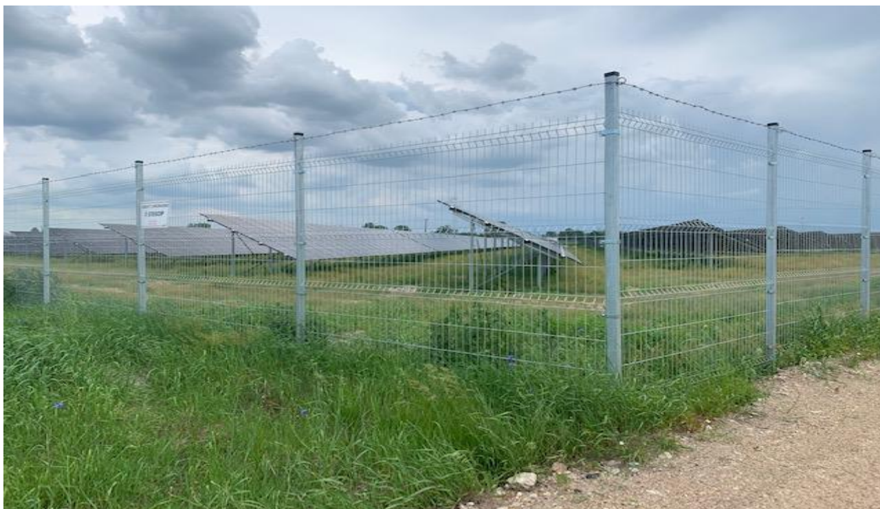
Fot. 9. Farma fotowoltaiczna za ażurowym ogrodzeniem.
