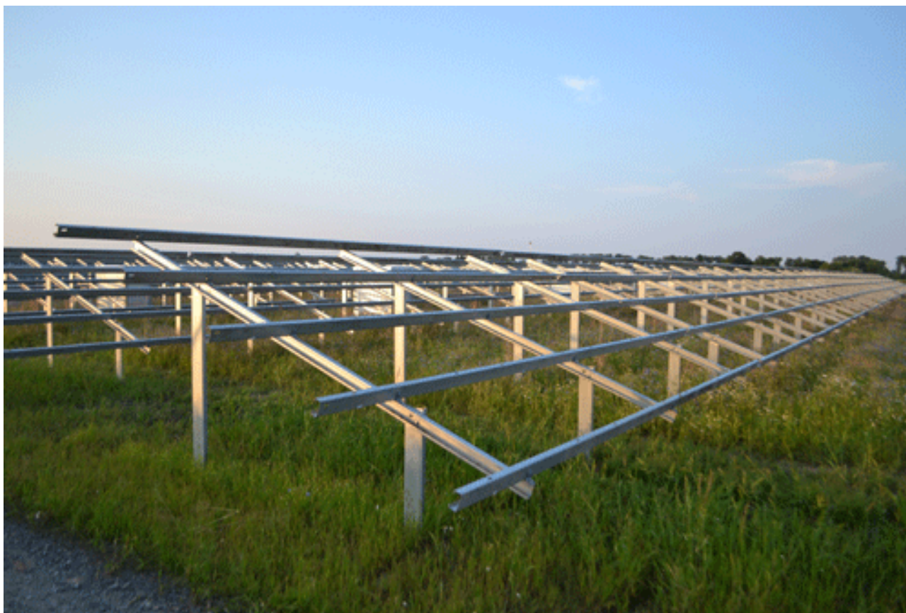
Fot. 2. Stalowa konstrukcja gotowa do montażu paneli fotowoltaicznych (źródło: www.projektsolartechnik.pl ).
