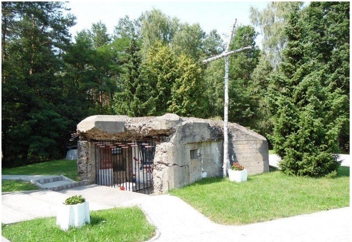
Rysunek 8: Pozostałości jednego z żelbetowych schronów pod Mławą.
