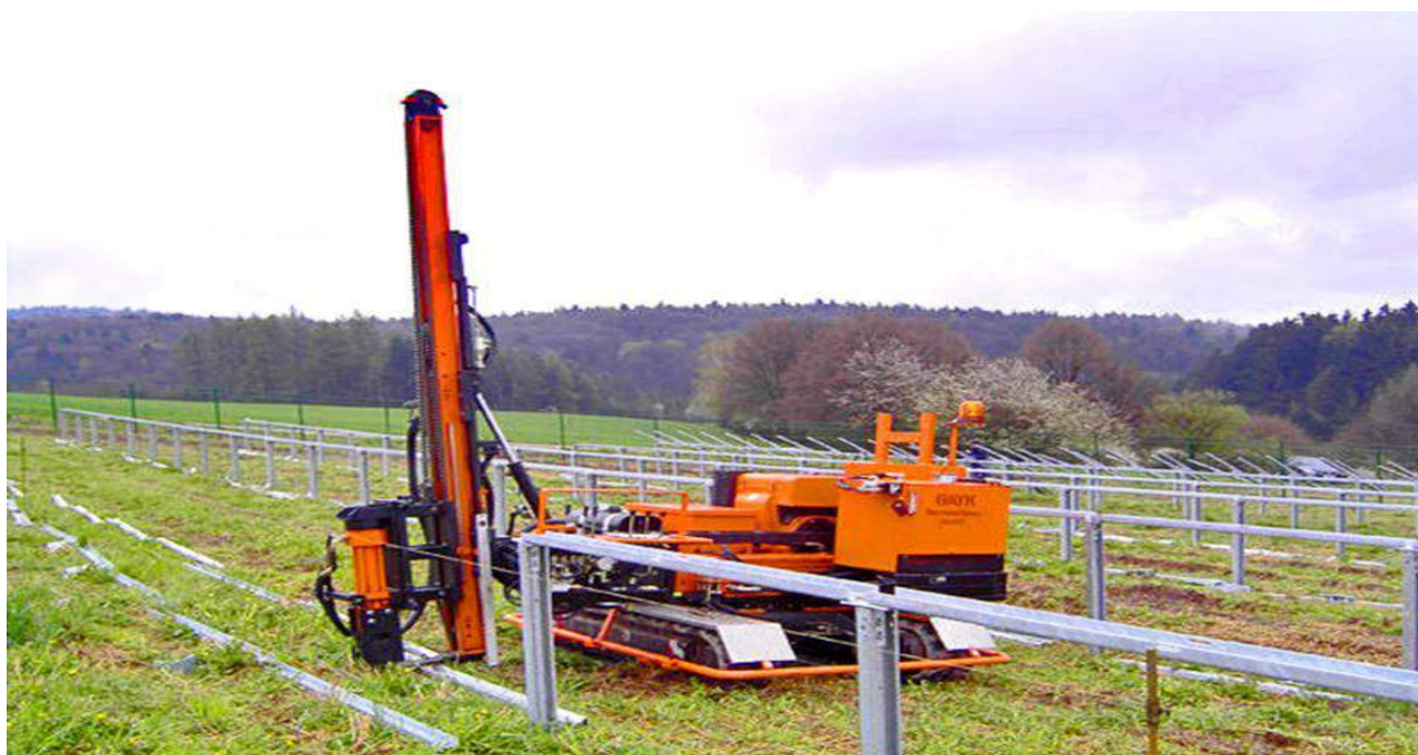
Fot. 1. Maszyna wciskająca konstrukcje stalowe w grunt (źródło: www.projekt-solarteknik.pl ).
