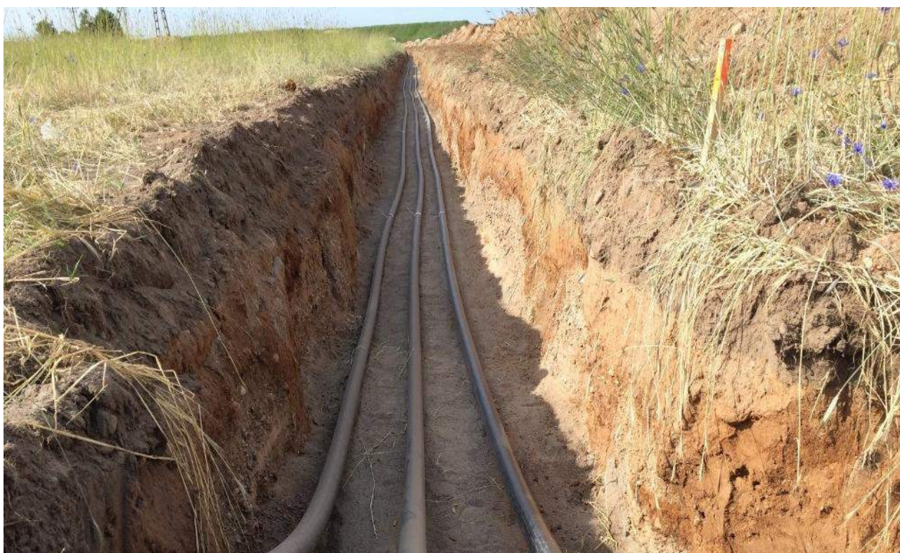
Fot. 4. Rów kablowy z ułożonymi przewodami (źródło: www.elektromontazwschod.pl ).
