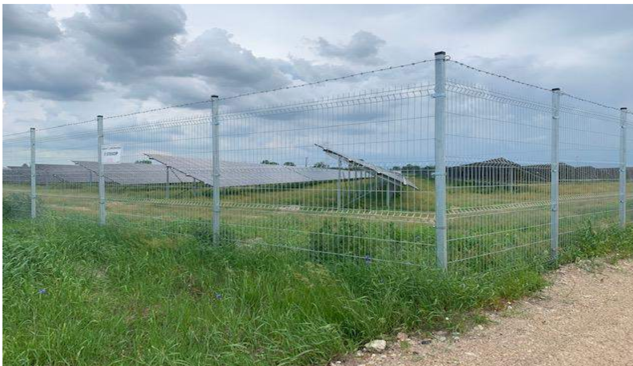
Fot. 9. Farma fotowoltaiczna za ażurowym ogrodzeniem.
