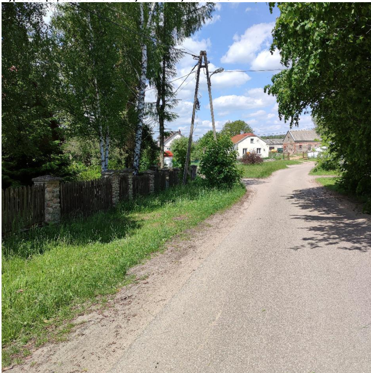
Zdjęcie 39 Część podobszaru rewitalizacji nr 1 – tereny zabudowane
