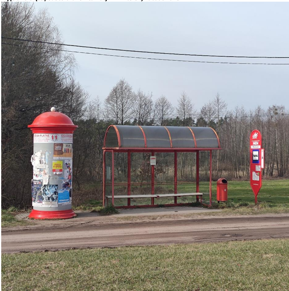
Zdjęcie 40 Część podobszaru rewitalizacji nr 1 – tereny zabudowane
