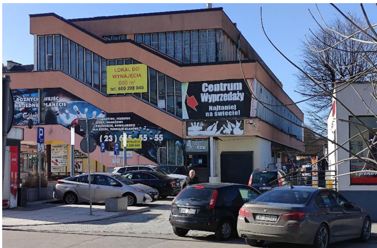
Zdjęcie 44 Wolne lokale użytkowe w Domu handlowym
