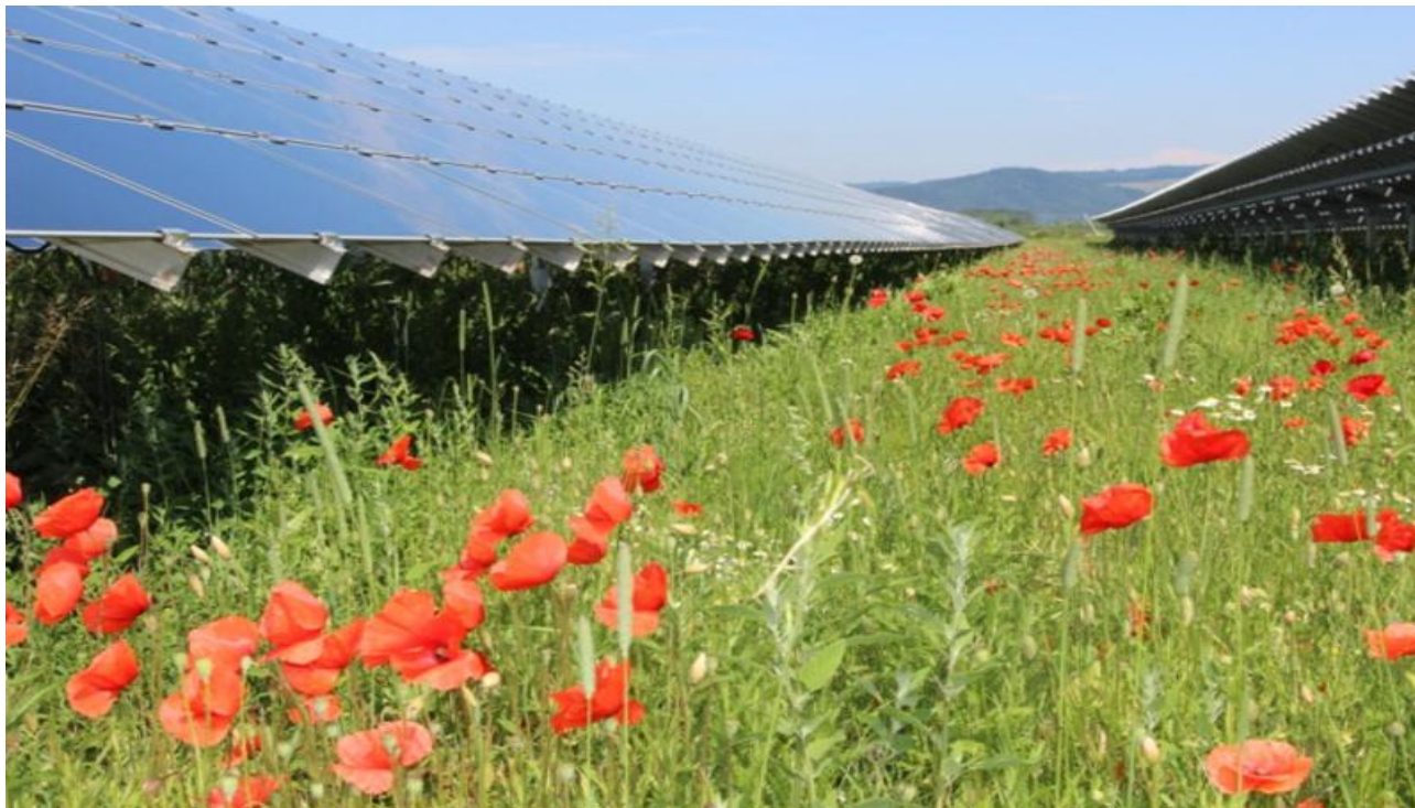
Fot. 4. Przykłady zróżnicowanej szaty roślinnej porastającej tereny farm fotowoltaicznych (źródło: „Solar power plants in the nature”, Belectric Solarkraftwerke GmbH).
