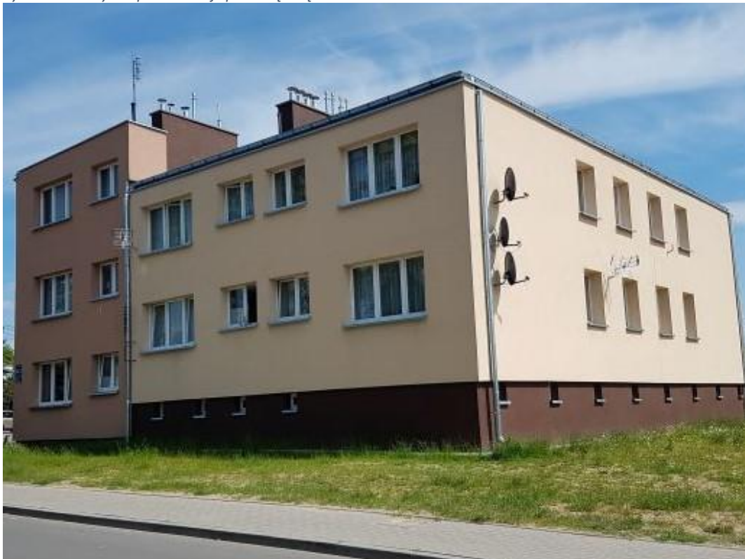
Rysunek 4 Budynek po realizacji przedsięwzięcia
