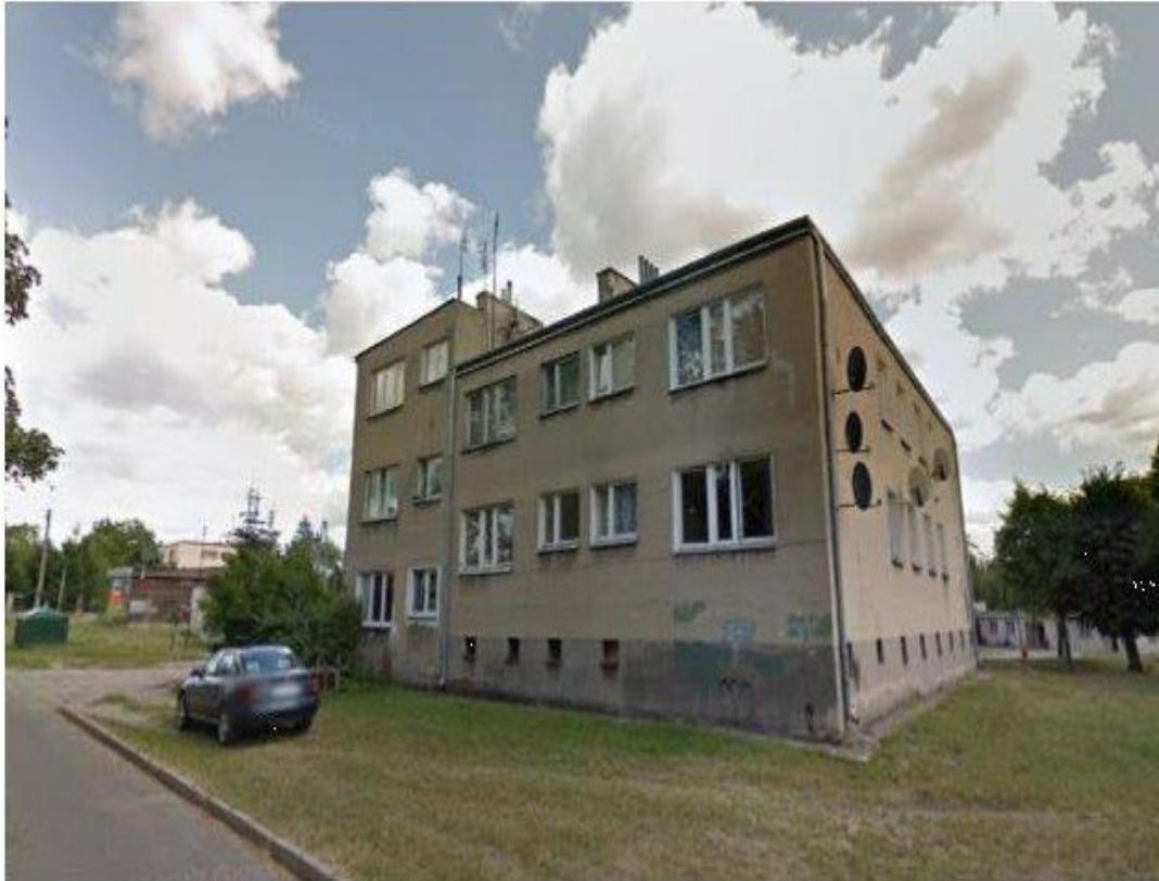
Rysunek 3 Budynek przed realizacją przedsięwzięcia rok 2016
