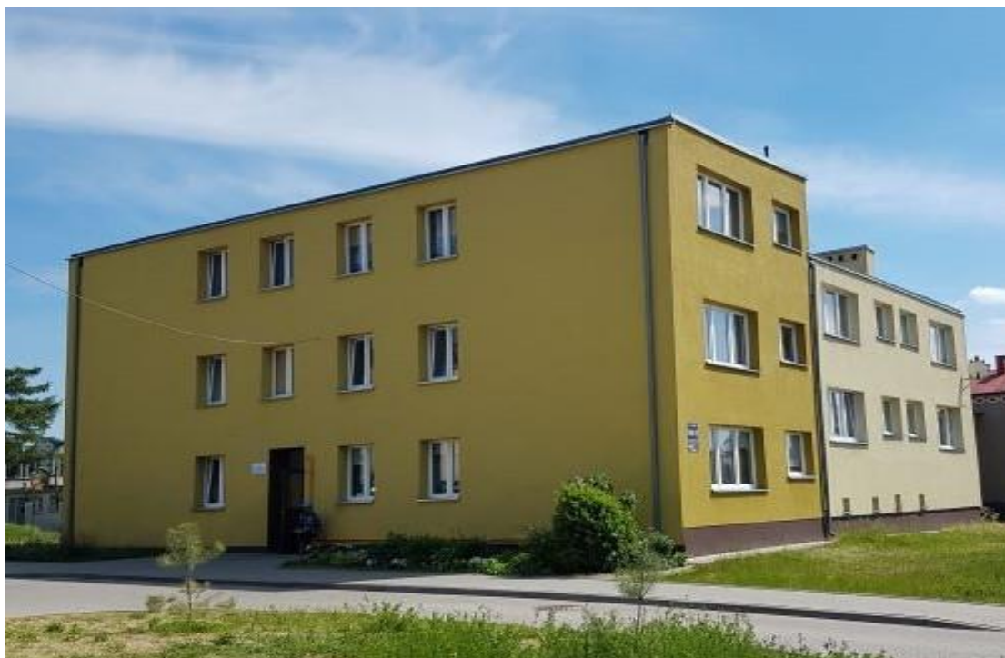
Rysunek 2 Budynek po realizacji przedsięwzięcia
