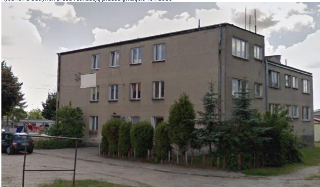
Rysunek 1 Budynek przed realizacją przedsięwzięcia rok 2016
