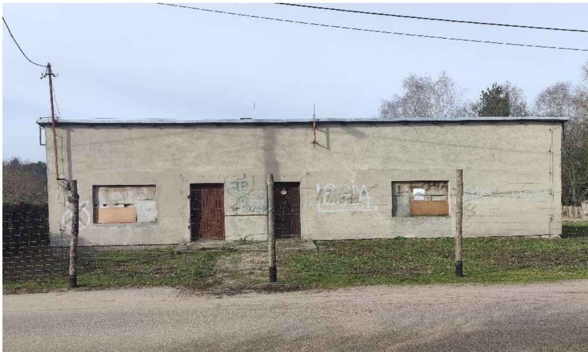
Zdjęcie 37 Budynek dawnej świetlicy osiedla Krajewo (2022 r.)
