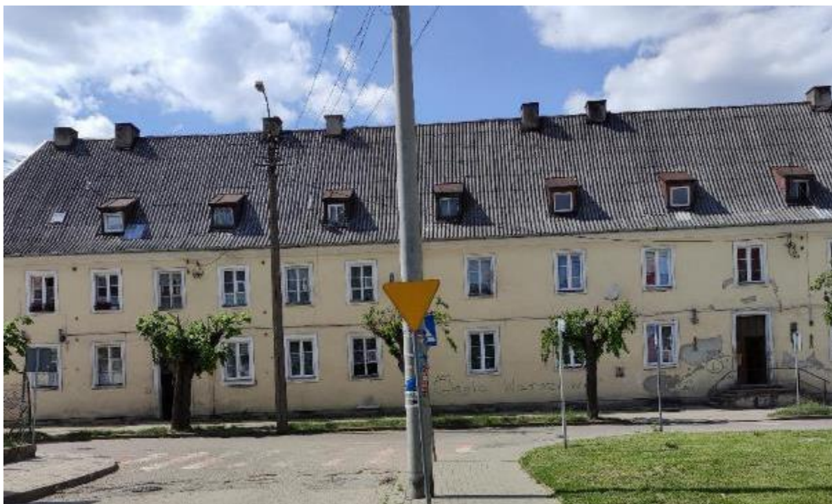
Zdjęcie 52 Zdjęcia budynków mieszkalnych przy ul. Słowackiego (2022 r.)
