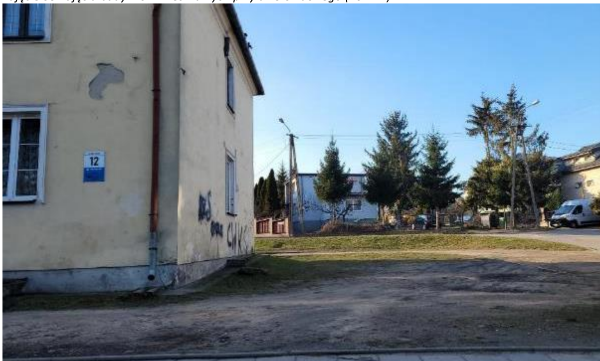
Zdjęcie 53 Zdjęcia budynków mieszkalnych przy ul. Słowackiego (2022 r.)
