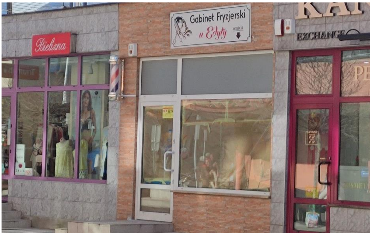
Zdjęcie 45 Wolny lokal użytkowy w sąsiedztwie Domu Handlowego przy ul. Wigury (2022 r.)
